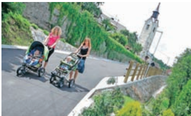
Obnovljeni cestni odsek v Otočah, v prostor umeščen s posebno pozornostjo do občutljivega vaškega okolja.
