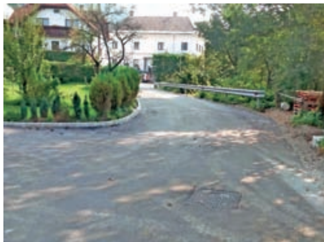
Naselje Moste je dobilo novo kanalizacijo in ostale komunalne vode.
