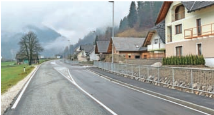
Na Studenem so zgradili pločnik skupaj s kanalizacijo, javno razsvetljava in uvozi na regionalno cesto.
