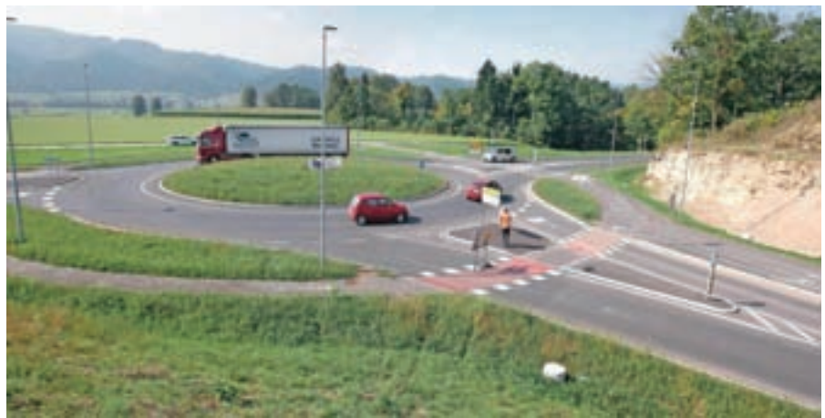
Novo križišče, ki regionalno cesto povezuje s cesto v industrijsko cono.
